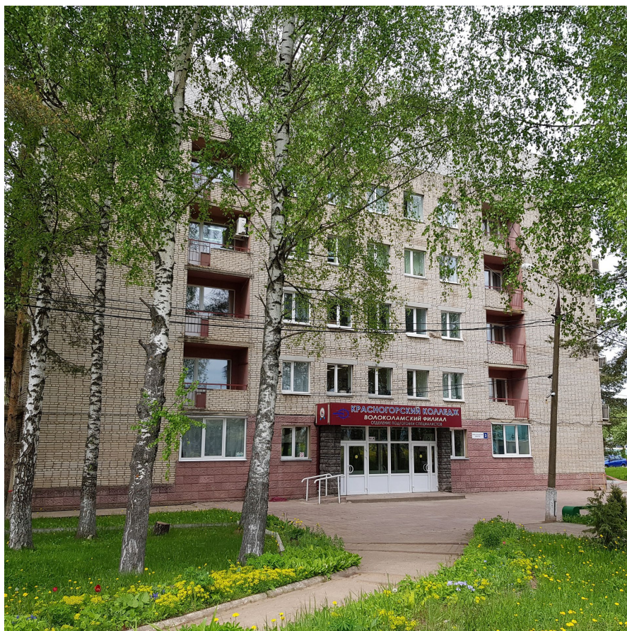
Рисунок 4.1 – Вид объекта внедрения методики перед началом работ по устройству навесного фасада
