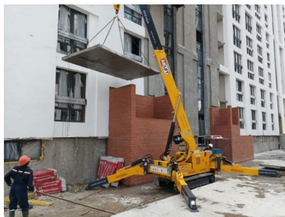
Рис. 2. Работа на строительной площадке [5]
