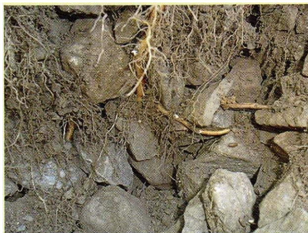
Рис. 2 Корневая система, органо–минеральные агрегаты и гумусовые вещества в балластном слое из щебня
