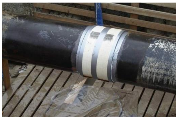
Рис 2. Пример установки муфты на поврежденный участок трубопровода
