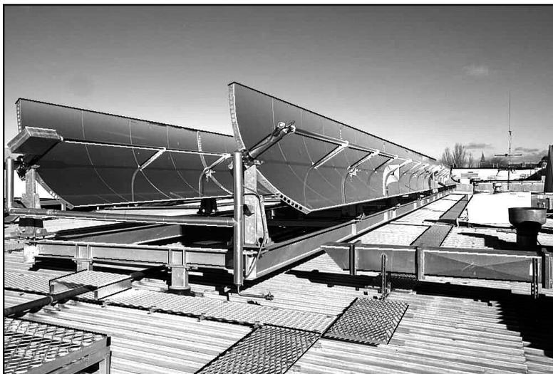
Рис. 1. Пример размещения установок солнечных концентраторов на конструкции покрытия производственного здания
