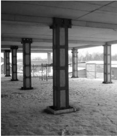
Рис. 1 Усиление конструкций с помощью стальных и железобетонных обойм
