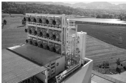
Рис.1. Установка по забору углерода из атмосферы на заводе в Швейцарии [5]
