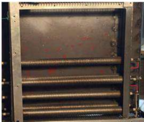
Рис. 2. Электроконвектор прямого нагрева [17]
