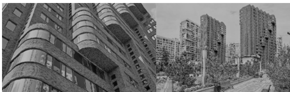
Рис. 3. Фасад университета; фрагмент кирпичной кладки.
