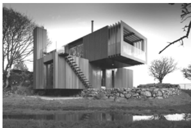
Рис. 2. Дом из контейнеров, с отделкой из дерева и металла
