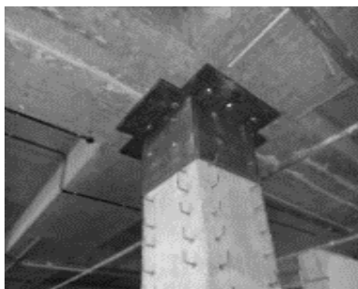
Рисунок 2. Усиление железобетонной обоймой
