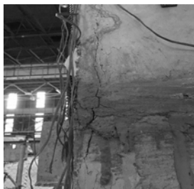
Рис 3. Раскрытие трещины
