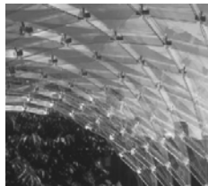
в сводчатые конструкции на основе ромбовидных панелей
