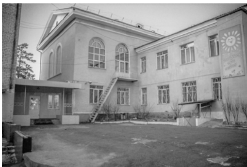
Рис. 1. Центр помощи детям им. Подгорбунского в Чите
