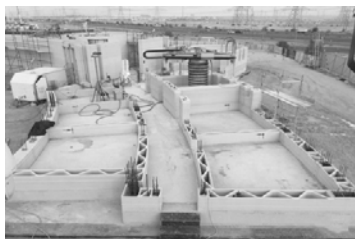
Рис. 1. Пример строительства с использованием 3d технологий
