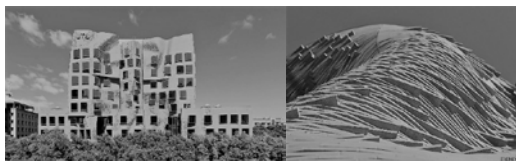
Рис. 2. Фасад университета; фрагмент кирпичной кладки.
