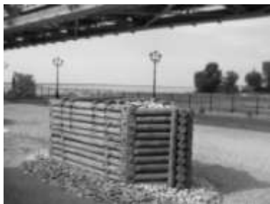
Рис.1. Макет мостового ряжа с ледорезом
