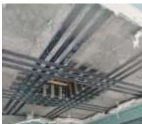
Рис. 3. Схема усиления проема в большепролетном перекрытии для пропуска инженерных коммуникаций
