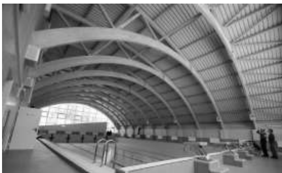
Рис. 1. Перекрытие бассейна из клееной древесины
