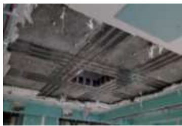
Рис. 3. Схема усиления проема в большепролетном перекрытии для пропуска инженерных коммуникаций
