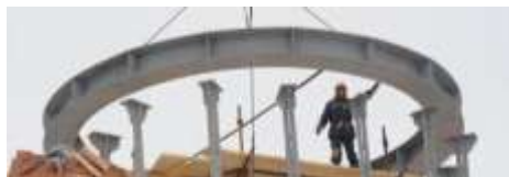
Рис.2. Конструкции опорных узлов
