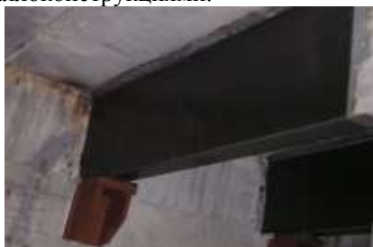
Рис. 3. Усиление путем наклеивания слоя углеволокна
