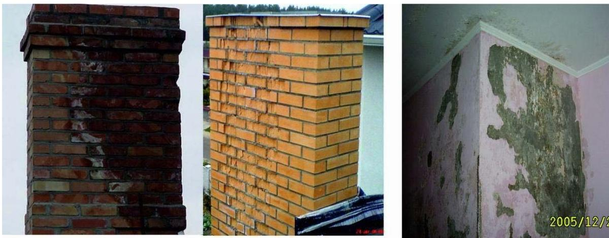
**Рис. 1.** Негативные последствия воздействия конденсата
