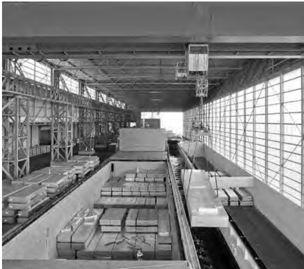
Рис. 1. Вид изнутри терминал Waterland, Амстердам
