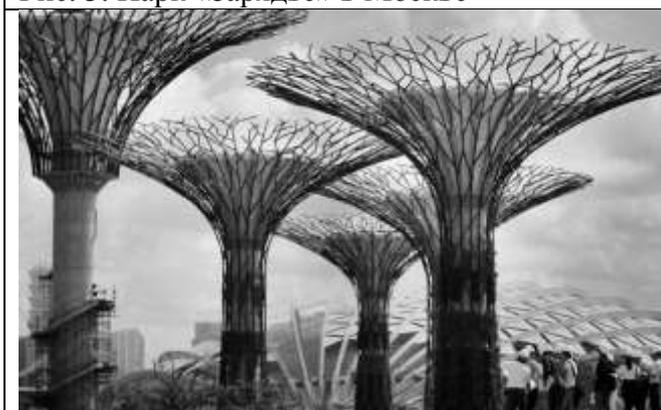
**«Supertree Grove» в Сингапуре.** Расположенные в тропическом парке сооружения выполняют множество функций для его жизнедеятельности - вентиляцию ботанического сада, сбор воды для полива растительности, с помощью резервуаров, электрогенераторы для выработки энергии, делая парк полностью автономным. Вся конструкция полностью озеленена натуральными насаждениями экзотических растений. Конструкция имитирует форму дерева, полностью вписывающегося в естественную среду паркового комплекса [8].
