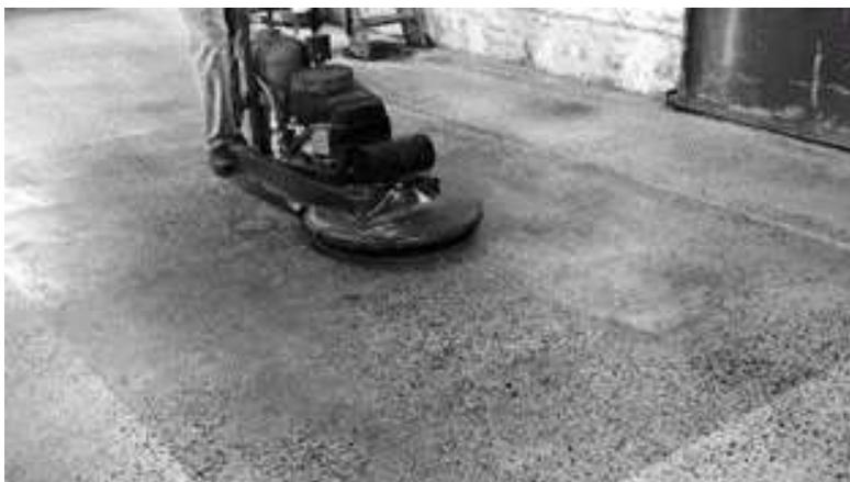
Рис. 1. Восстановление покрытия из декоративного бетона
