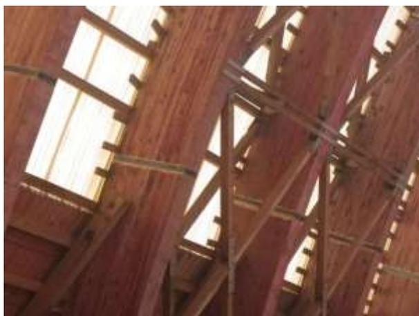
Рис. 1. Пример усиления деревянной арочной конструкции
