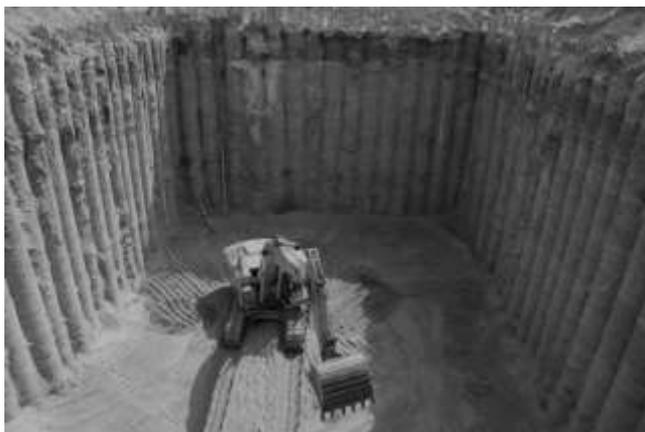
Рис. 2. Стена в грунте с использованием буросекущих свай
