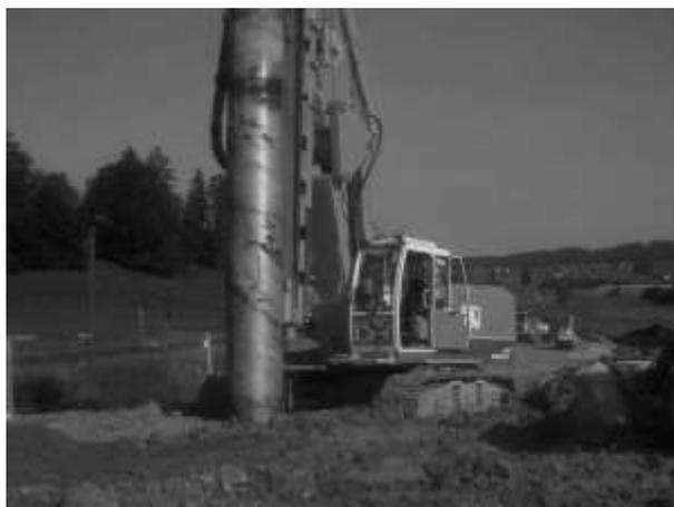
Рис. 4. Бурение с применением инвентарной обсадной трубы.
