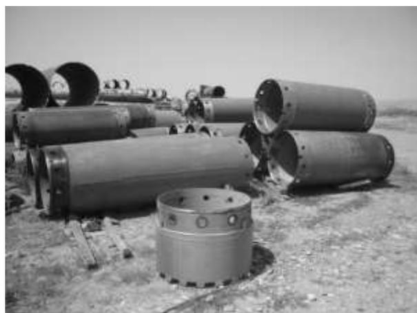
Рис. 4а. Секции обсадных труб, режущий наконечник
