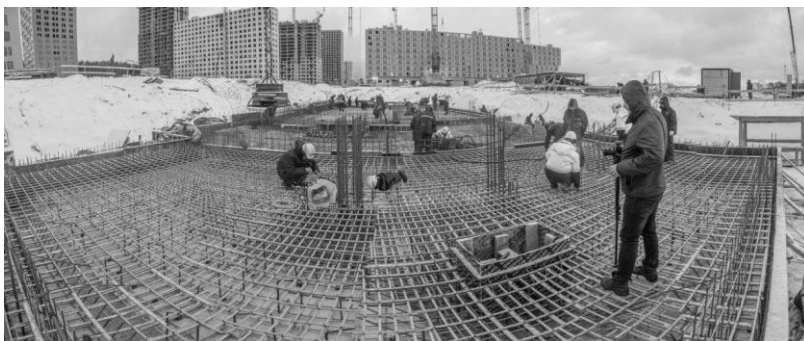
Рис 2. Каркас фундаментной плиты из стеклопластиковой арматуры
