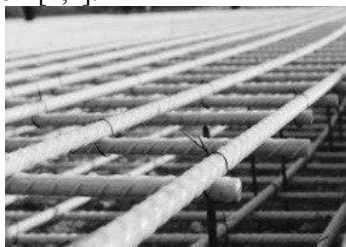
Рис. 2. Крепление АКП проволокой
