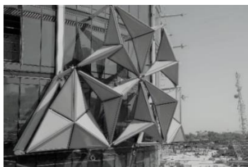
Рис. 1. Монтаж динамического фасада. Башни Аль-Бахар. Архитектурное бюро Aedas Architects. ОАЭ
