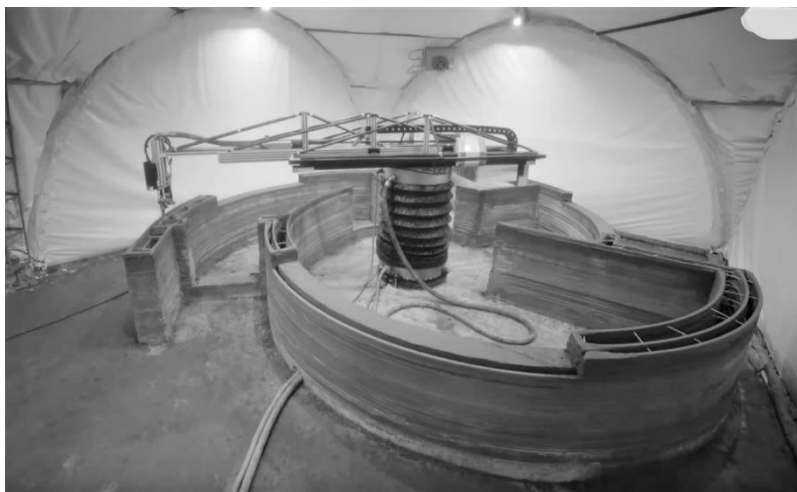
Рис.1. Процесс возведения дома с помощью технологии 3D-печати компанией «Апис-кор инжиниринг»
