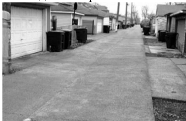
Рис. 1. Двухмильный участок дороги в чикагском пригороде, уложенный с использованием биодинамического бетона
