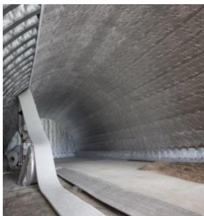
Рис.2. Монтаж изоляционной оболочки ангара
