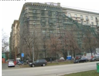
Рис. 1 Общий вид обследуемого здания
