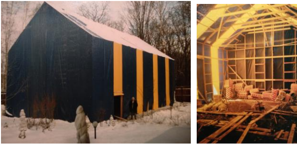
Рис. 3. Тентовое укрытие на деревянном каркасе над строящимся зданием.
