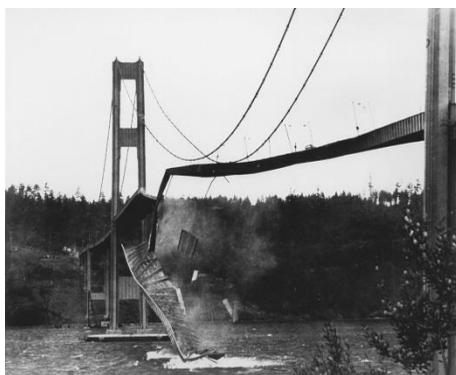
*Рис. 3. Обрушение Такомакого моста*
