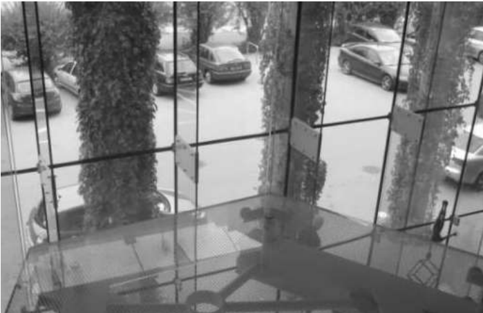
Рис.3. Несущая стеклянная конструкция.
