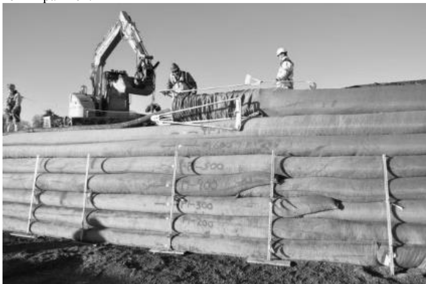
Рис. 1. Формирования вертикального укрепляющего барьера
