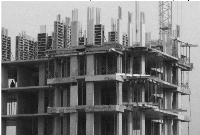
Рис. 1. Возведение монолитного здания
