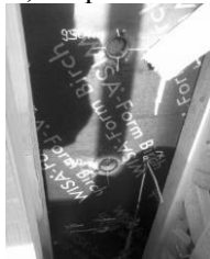
Рис.2. Контрольные окошки в опалубке для определения схватывания смеси нижних слоев
