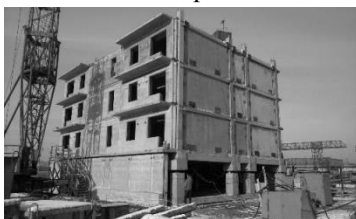
Рис. 1. Фрагмент несущего каркаса системы «КУПАСС»
