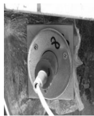
Рис. 3. Датчик давления в опалубке
