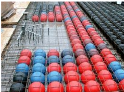
Рис. 1. Устройство перекрытия по системе «Bubble Desk»
