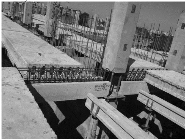
Рис. 2. Устройство сборно-монолитного каркаса
