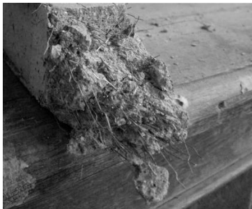
Рис. 1. Использование металлической фибры в мелкозернистом бетоне
