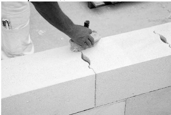
Рис.2. Монтаж пазогребневых блоков
