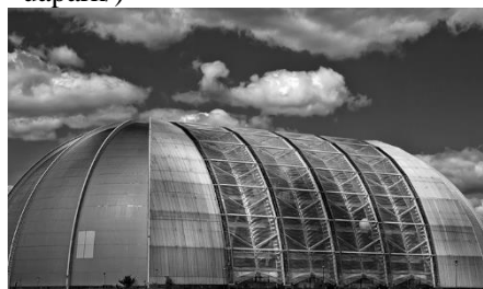
Рис 3. Аквапарк Тропические острова (Германия): Арочная форма металлических ферм (Источник: https://www.sattler-global.com )
