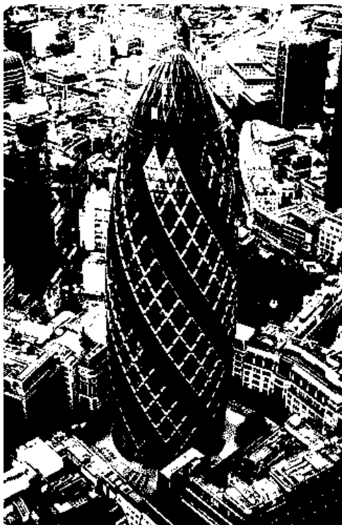
Рис. 1. Башня-небоскреб Мэри Экс
