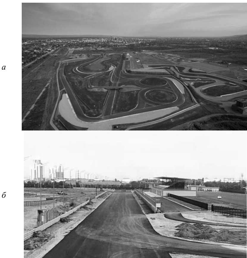
Рис.3. Автодром во время строительства. А - общий вид [8]; б- строительство скоростного участка [9]
