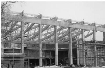
Рис 1. Аквапарк «Ква-Ква парк» (Россия, Москва): Линзообразная форма ферм покрытия (Источник: http://www.zaotimber.ru/all/build/aquapark/ )
