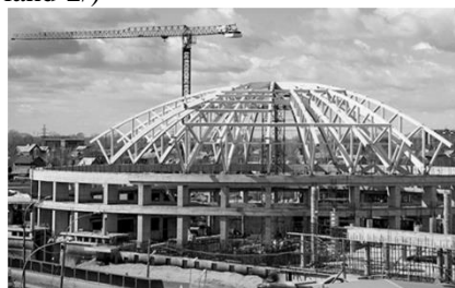
Рис 4. Аквапарк Аквумир (Россия, Новосибирск): Фермы из клееной древесины (Источник: http://amacumara.ru/2012/02/piterland-2/ )
