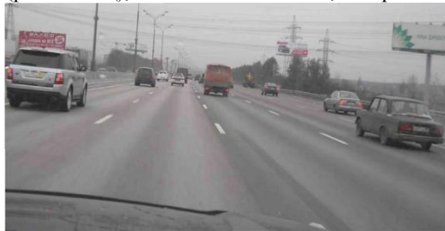
Рис. 3. Дорожное покрытие из сероасфальтобетона на МКАД
