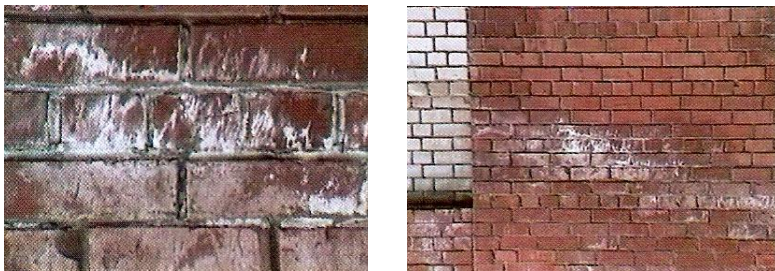
Рис. 1. Результаты физической коррозии цементно-песчаного раствора фрагмента кирпичной кладки
