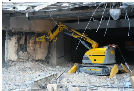
Рис. 1. Деконструкционные работы в ограниченном пространстве
