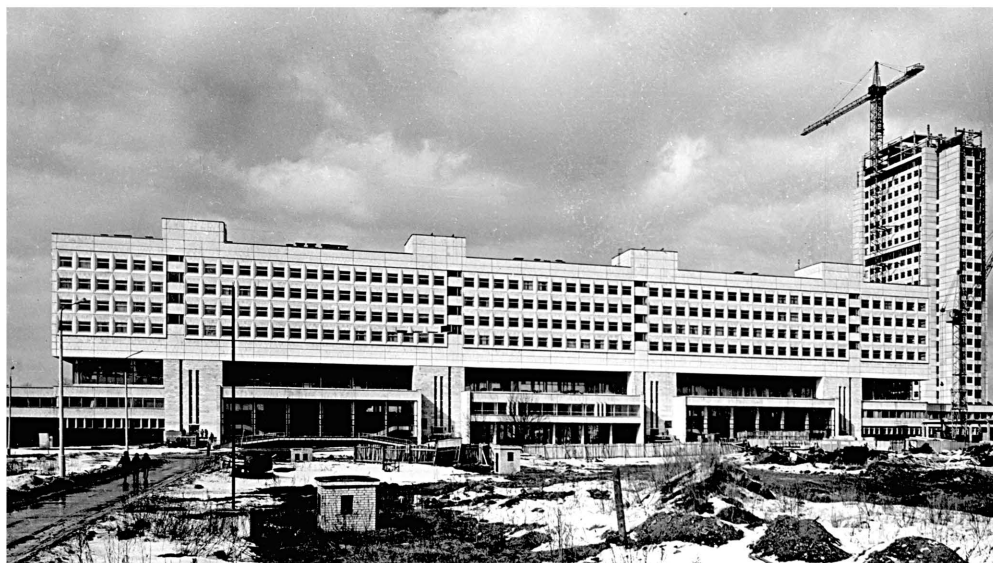
Строительство Большого МИСИ
